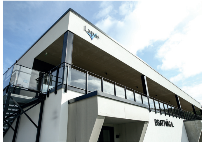
Brødrene Midthaug har levert rekkverk. Ellers ser vi det er STO-puss og Frontex sementbaserte fasadeplater på denne delen av fasaden mot øst.
